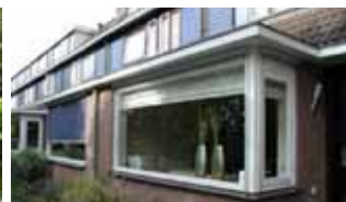
Uitbouw die in hoogte en breedte goed aansluit op de goothoogte van het gebouw.
