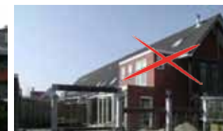
Uitbouw die in hoogte en detaillering niet goed aansluit.
